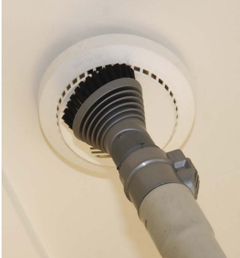
با جارو برقی هشدار دهنده های دود smoke alarm را گردگیری کنید
