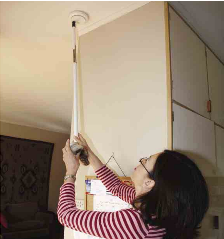
Controlla settimanalmente l'allarme antincendio
