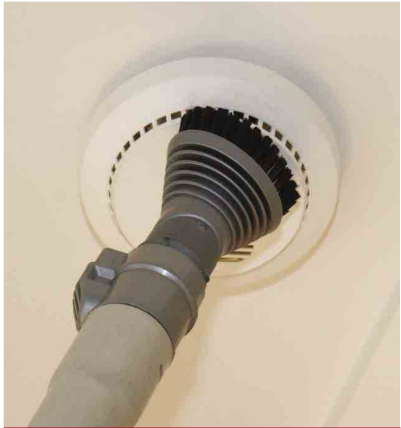
用吸塵器為煙霧報警器除塵
